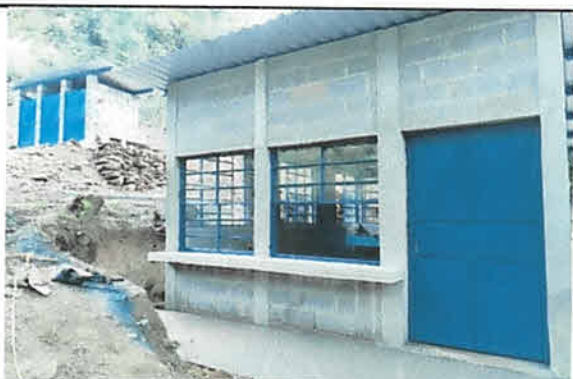
FOTO 3: COCINA TERMINADA CON PAREDES DE BLOCK, VENTANAS DE METAL Y VIDRIO MAS PUERTA DE METAL CON PISO DE CONCRETO Y BANQUETA ALREDEDOR
