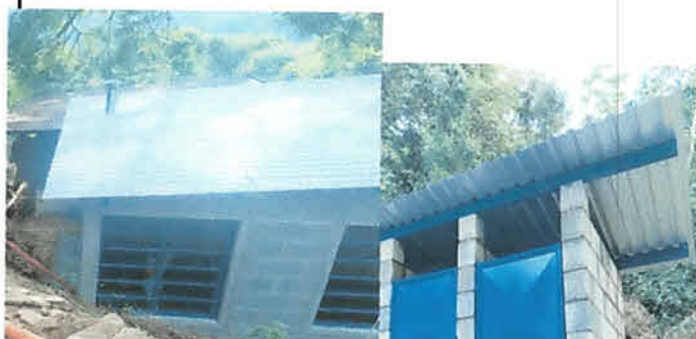
FOTO 4: TANTO LA COCINA COMO EL MODULO DE SANITARIOS CUENTA CON ESTRUCTURA DE COSTANERA DE METAL Y CUBIERTA DE LAMINA TROQUELADA DE ALUZINC NUEVA
