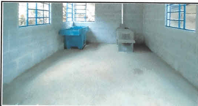
FOTO 5: PISO DE CONCRETO FUNDIDO EN COCINA Y SERVICIOS SANITARIOS CON ACABADO FINAL DE CERNIDO REMOLINEADO
