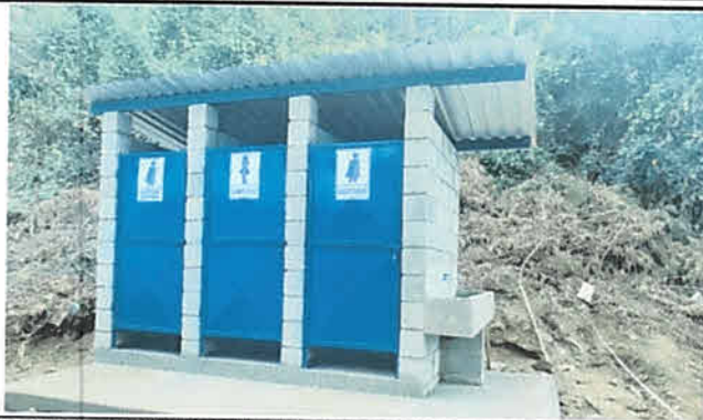
FOTO 1: SE CUENTA CON EL MÓDULO DE SERVICIOS SANITARIOS TOTALMENTE TERMINADO CON SUS CONEXIONES DE AGUA Y DRENAJE INSTALADAS
