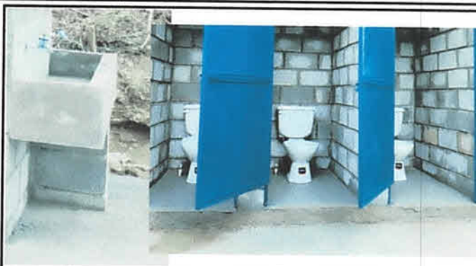
FOTO 2: EL MÓDULO DE SANITARIOS CUENTA CON LAVAMANOS DE CONCRETO Y TRES TAZAS SANITARIAS
