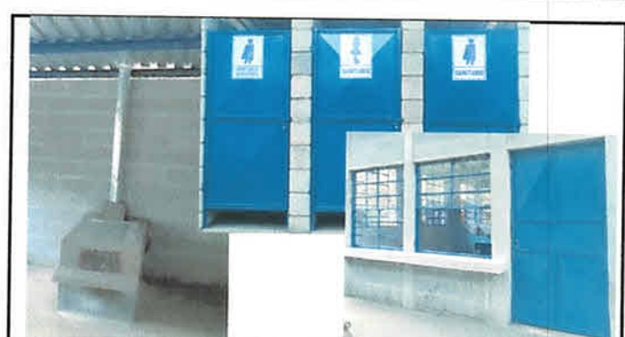
FOTO 6: ESTUFA TERMINADA ASI COMO LAS CUATRO PUERTAS Y SIETE VENTANAS DE METAL.
